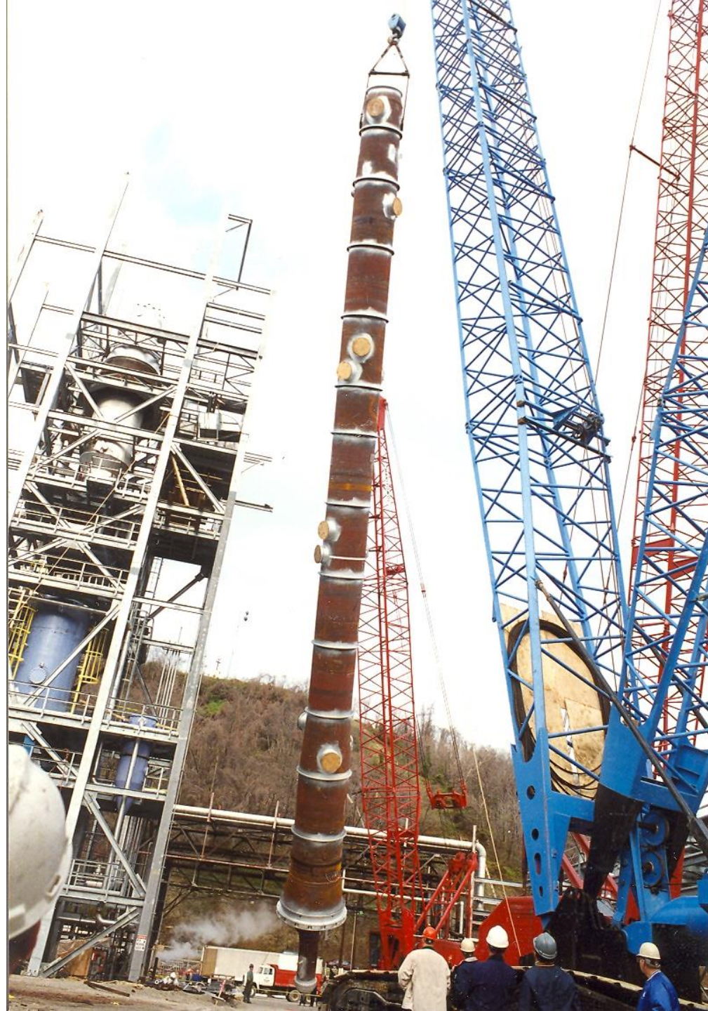
350 ton lift crane
